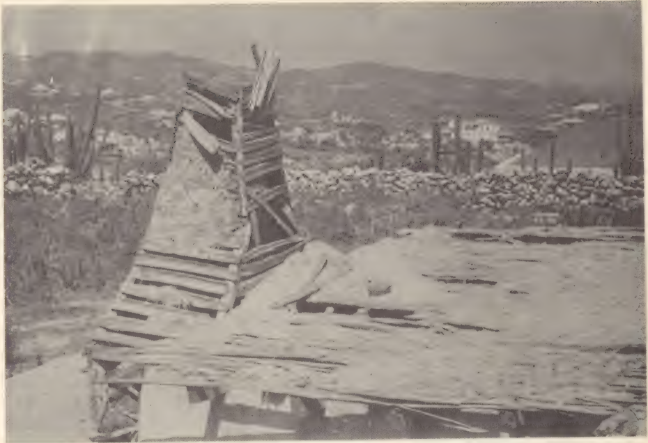
Dak- en rookafvoerconstructie
